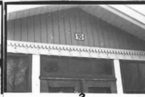
veranda 3 I detalj
