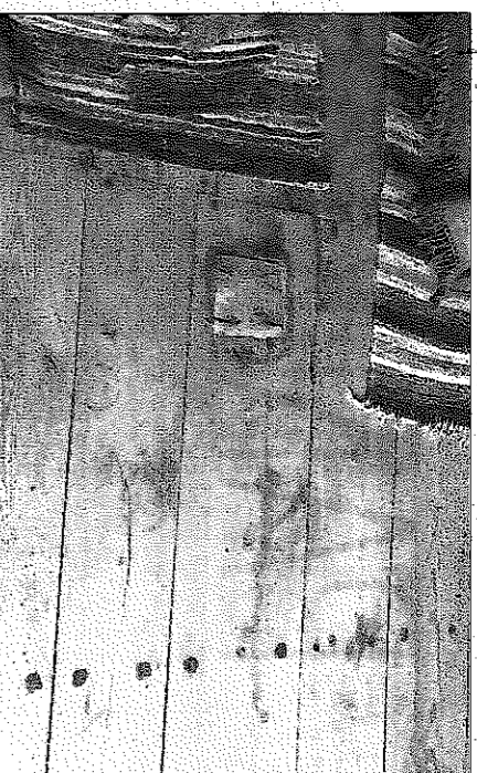
TETTA: Oppe på loftet er det lett å sjå at holet for kolehatten er tetta att med ein tre-kloss. Silk er det også i Påskhella på Fiskerimuseet, i Pålgarden (frå Løvikel) på Romsdalsmuseet og i Løvikremma på Gossen.
