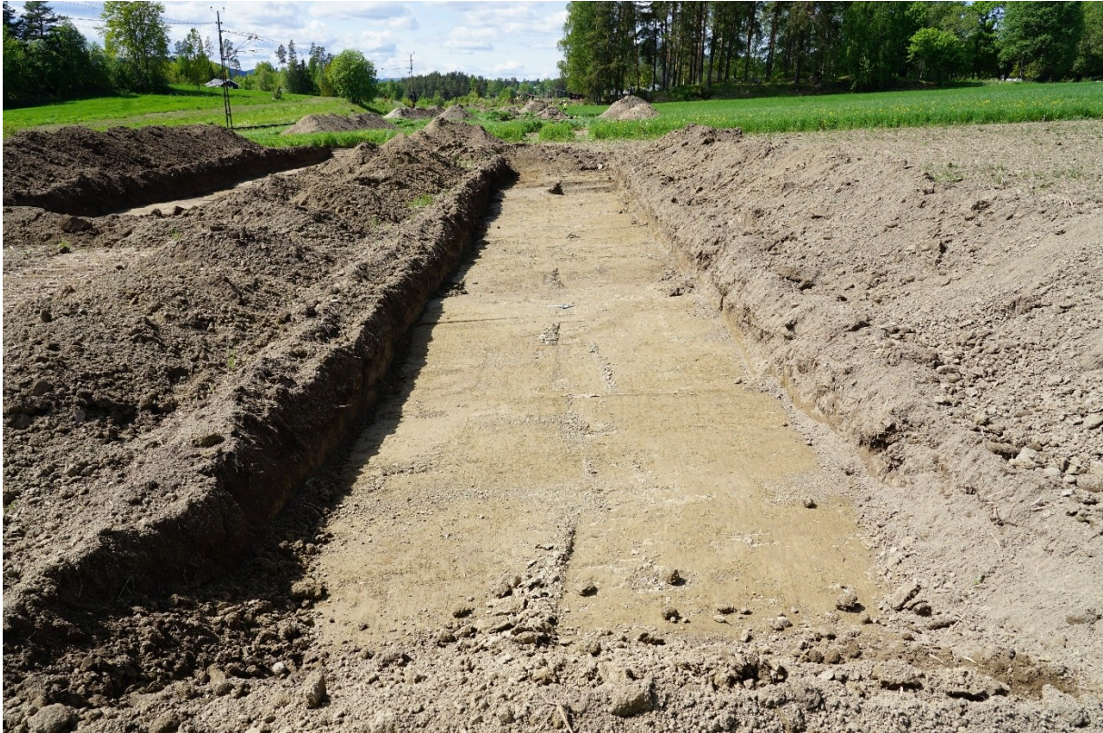
Figur 11. Schakt 6. 0,56 m tjock matjord och lera-silt i botten. Foto från öster.
