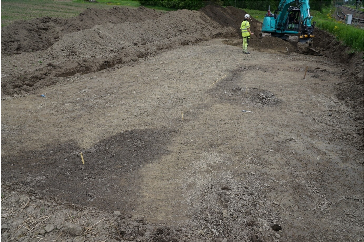
Figur 19. Arbetsbild. Maskinarbete i schakt 11. Foto från väster.
