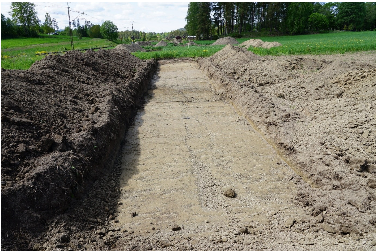
Figur 10. Schakt 5. 0,46 m tjock matjord och gul lera-silt i botten. Foto från öster.
