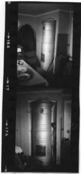
detalj, ovanlig kakelugn klädd med galvaniserad plåt
