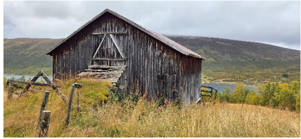
Driftsbygning med fjøs og låve. Foto: Nina Espeseth Grønbrekk
