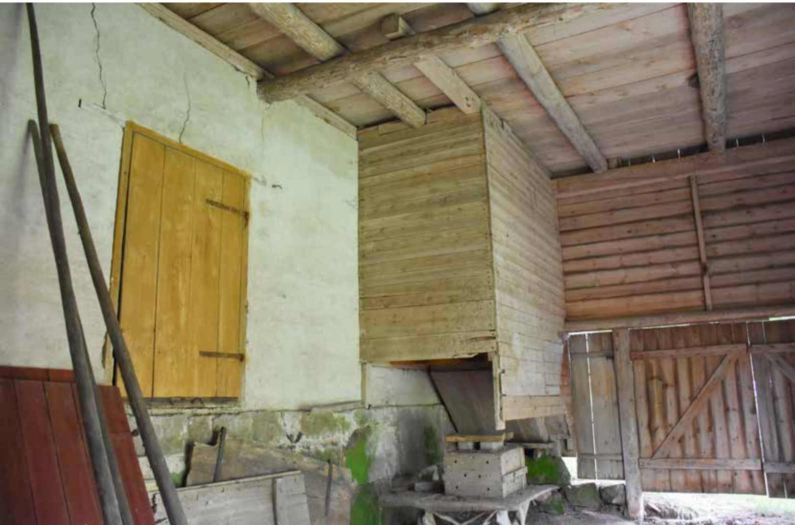
Ovan: dyngstaden till ladugården är inbyggd med panel på stolpverk.
