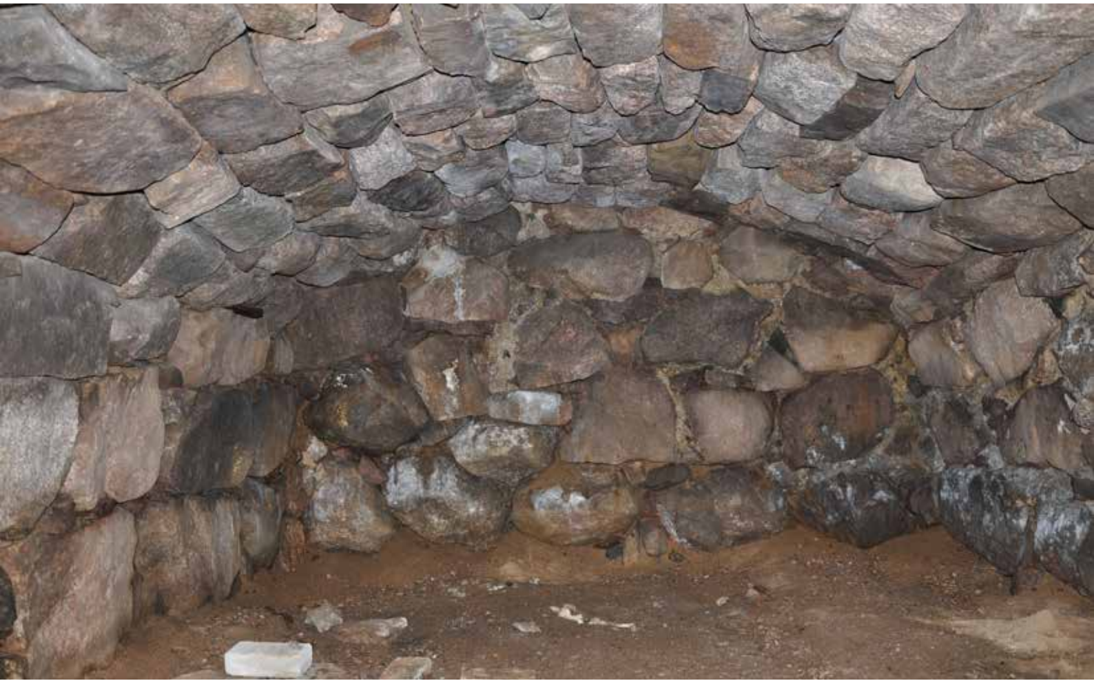
Ovan, jordkällaren under parstugan med kallmurat valv i imponerande storlek.
