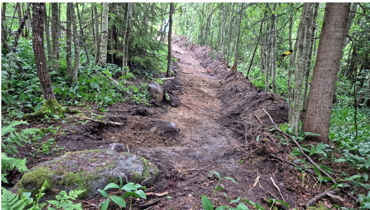
Figur 15. Sydvästra delen av schaktet. Foto från sydväst.
