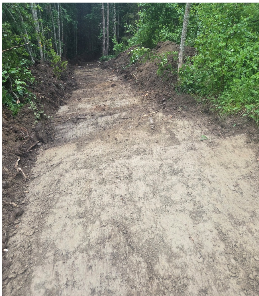
Figur 16. Nordöstra delen av schaktet. Foto från nordöst.
