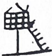
Njalla förrådsbod på en rotfast stam
