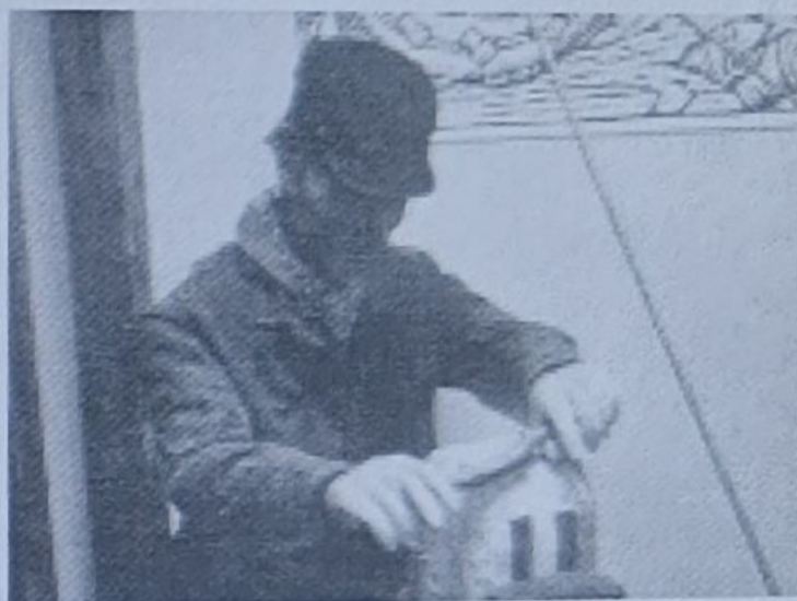
Blockmakare i arbete
