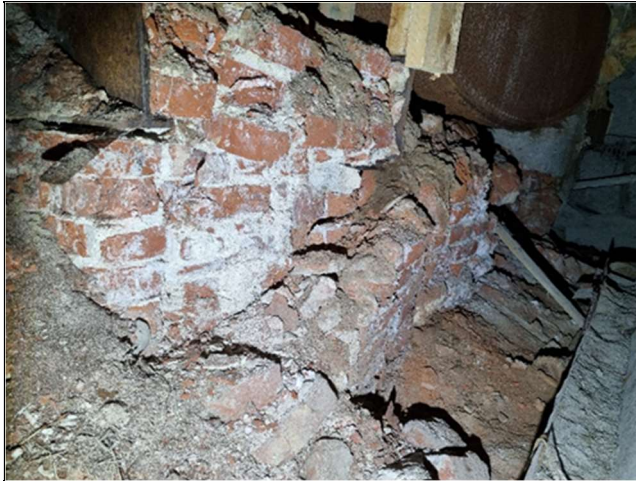
Østre fundament på vestre lutkar. Kraftig forvitret og nært utrasing.
