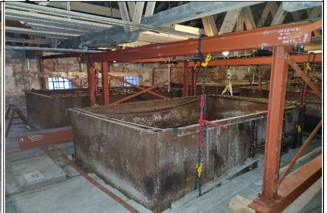
Sikringskonstruksjonen er på plass, hjørne på lutkaret er jekket opp og vekta på begge lutkarene er overført til sikringskonstruksjonen.
