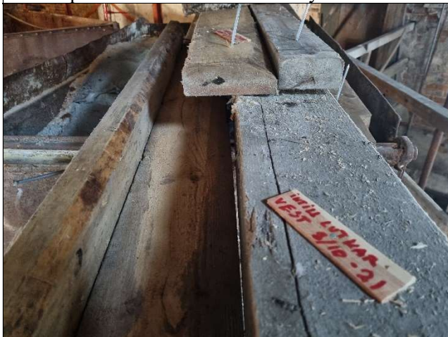
Noen bord i gulvet måtte demonteres for å komme til med jernsøylene opp fra kjelleren. Disse er merket og lagret på stedet.
