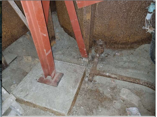
Nytt fundament for bæring av sikringskonstruksjonen. Bak det nye fundamentet ses søyla som bærer fremre del av lutkaret. Denne sto på et betongfundament som delte seg i to og søyla falt ned 30-40 cm
