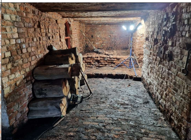
Samme sted etter sanering.
