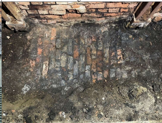
Bilde tatt på varpas utside. (område D) For å få oversikt over skader og for å komme til med reparasjoner ble det fjernet svartstoff i et en meter bredt felt langs varpas øst og nordside. Massene bestod mest av svartstoff iblandet noe huggflis.
