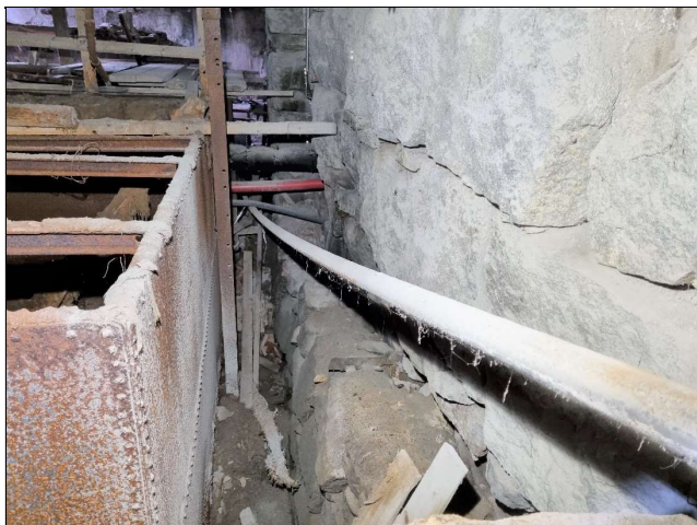
Bilde tatt vestover langs nordvegg på luthuskjellerens nederste nivå. (område R) Dette området ble tilgjengelig for sanering når teglfundamentet på de vestre silkarene ble revet.
