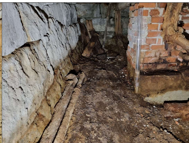
Bilde tatt samme sted etter sanering, kalken er fjernet ned til svartlut-laget. I høyre bildekant ses det østre fundamentet på det østre silkaret. Akrylrør presset ned i kalken viser kalknivå før sanering.
