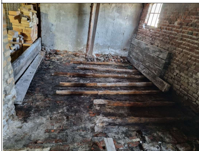
Plankegulv og plater som sodaen hadde vært lagret på ble merket, rengjort og flyttet unna. Sodarester i «bjelkelaget» og andre steder ble suget opp.
