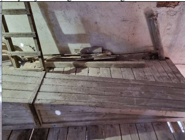
Samme sted etter sanering. Murpuss og rusk er fjernet. Plank og andre gjenstander ligger igjen.
