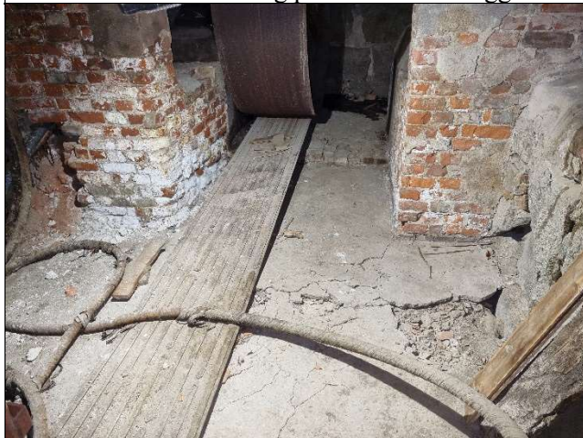
Remkanal, bilde tatt mot øst. Mur og pussrester på gulv er fjernet.
