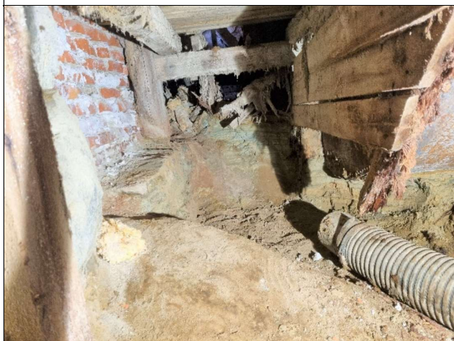
Bilde tatt sørover mellom mikseritankene og de østre silbarene. Fjerning av kalkmasser er godt i gang. Midt i bildet ses restene av trappa som har gått ned her.
