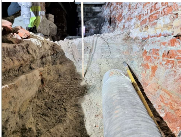
Bilde samme område. Remkanalvegg til høyre. Granittfundamentet til teglveggen ble avdekket, dermed brytes muligheten for at vann og salt kan bevege seg kapillært inn i teglmuren.
