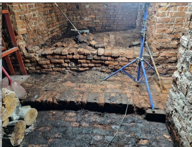
Samme sted etter sanering.
