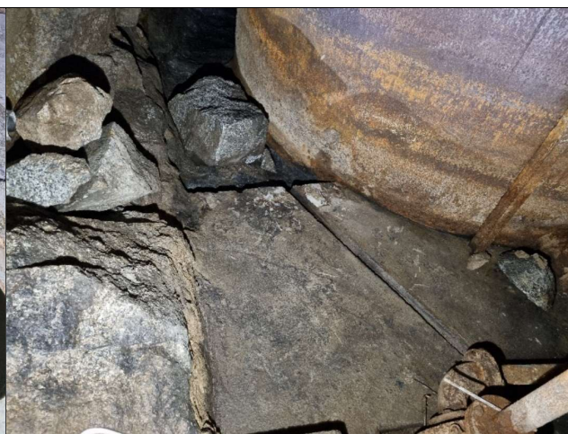
Samme sted etter sanering. Kanalen er rensket og bygningsavfallet bestående av sand, mur og mørtelrester som var dumpet mellom tank og kjellervegg er fjernet.
