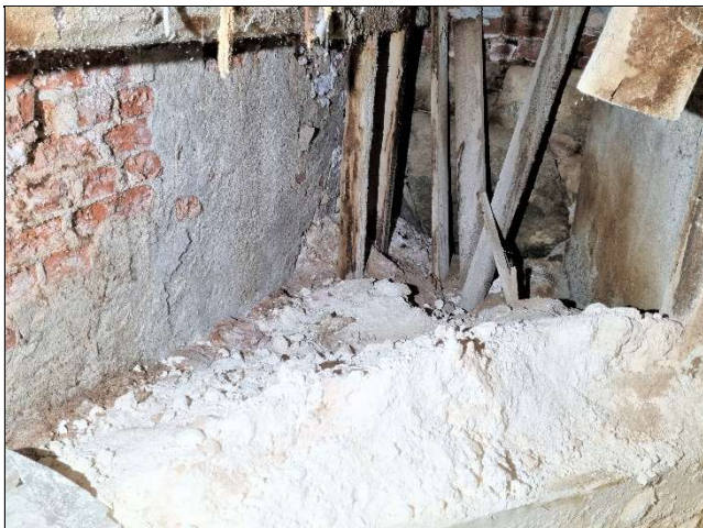
Samme sted som forrige bilde, men bak tverrveggen lengst nord. Kalk ligger inn mot mikseritank-fundamentet til venstre.
