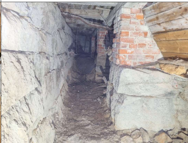
Samme sted som forrige bilde etter sanering.
