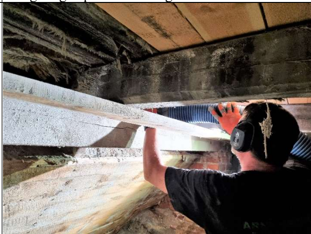
Bilde samme område. Mesakalk som hadde samlet seg på horisontale flater drysset stadig ned og gjorde det utfordrende å arbeide, mye av det ble suget vekk.
