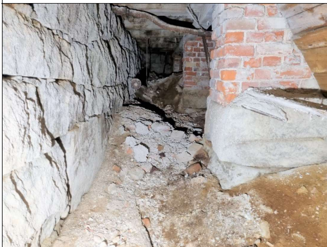
Bilde tatt østover langs luthuskjellerens nordvegg før sanering. Nærmest ses det østre tegl-fundamentet på de midterste silkarene. (område P)
