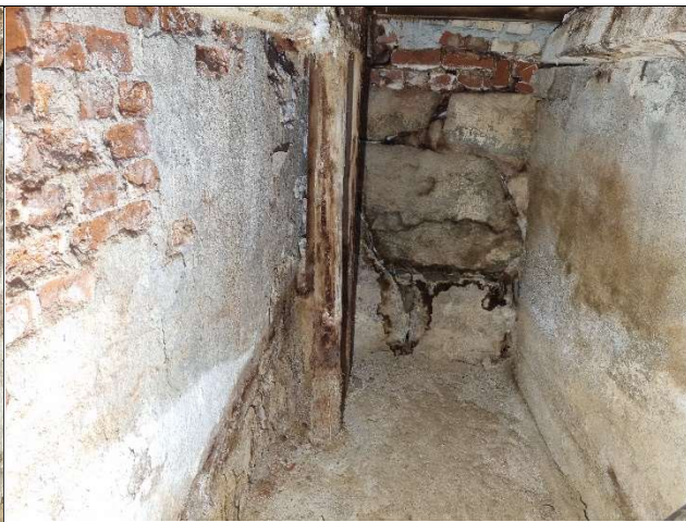
Samme sted som forrige bilde ferdig sanert.
