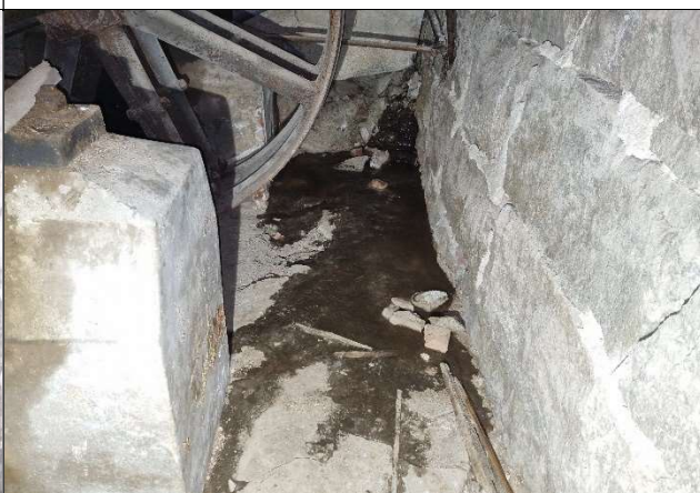
Samme sted etter sanering.
