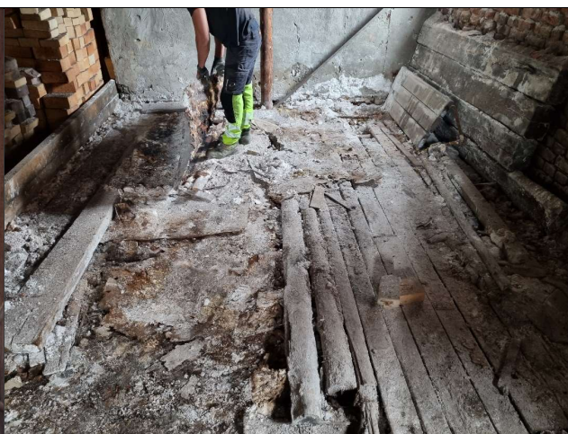
Samme sted 2023. Det lå igjen mye sodarester under gulv og i kriker og kroker etter den forrige saneringen
