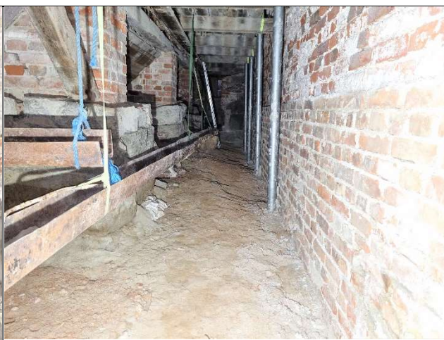
Bilde tatt samme sted etter sanering og reparasjon av remkanalvegg. (se egen rapport) Dekke-støttene avlastet vekta av taksperrer under murarbeidet.
