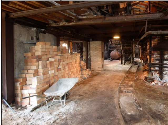
Bilde tatt langs skinnegangen øst for sodaovnen av O.T Ljøstad i 2005 (manglet nyere bilde av dette området) Gulvet er dekket av et lag subbus. Subussen er lagt på i museumstid.
