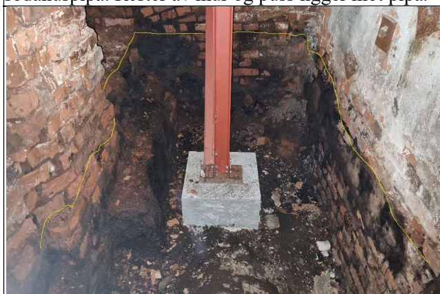
Bilde tatt sørover på vestsiden av varpa. (område B) For å få på plass fundamentet til varpas sikringskonstruksjon ble det fjernet masse bestående av svartlut og mursteins-rester ned til fjell. Gul strek viser massenes nivå før sanering.
