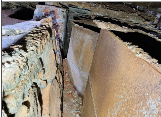
Bilde tatt sørover langs muren mellom luthuskjellerens to nivåer. (område Q) Området ble tilgjengelig for sanering når teglfundamentet på de vestre silkarene ble revet.
