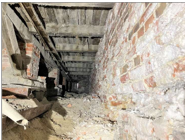
Luthuskjeler nivå 2 før sanering. Bilde tatt østover langs remkanalveggen.
