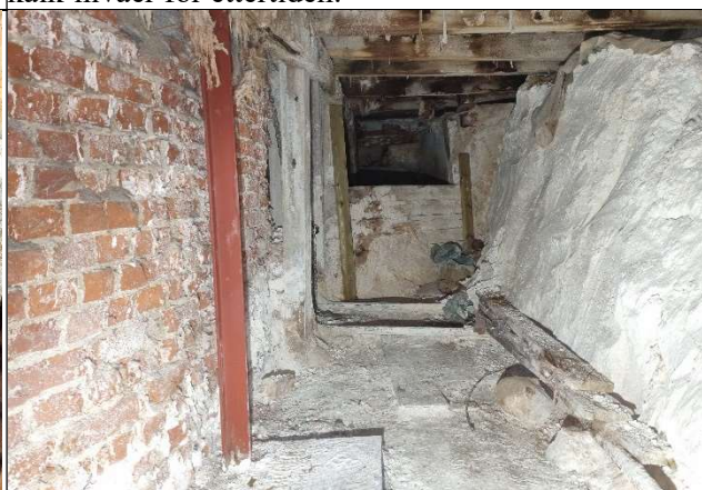
Bilde samme sted etter sanering. Mikseritank-fundamentene til venstre er avdekket slik at de kan repareres. Resten av kalken får ligge urørt.
