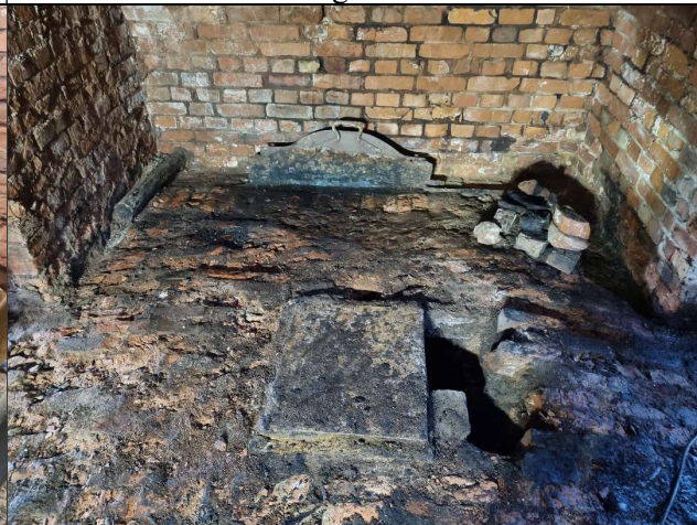
Samme sted etter sanering.
