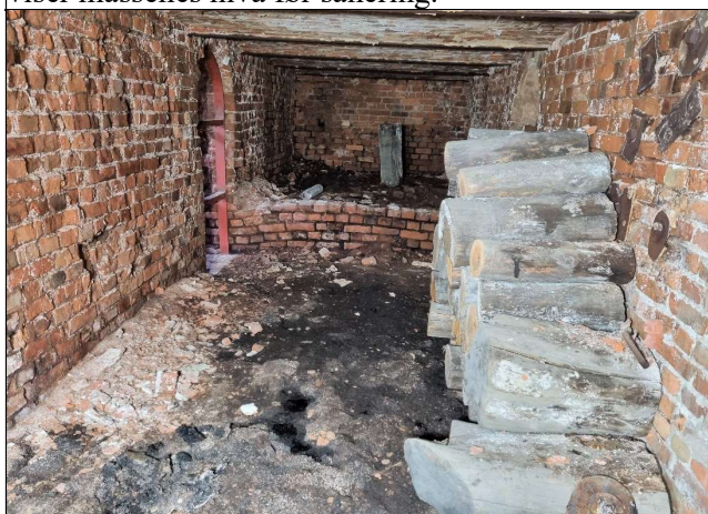
Bilde tatt mot sør under varpa. (område C) Gulvet er dekket med 10-20 cm svartlut. Langs veggene ligger mye forvittringsnedfall.
