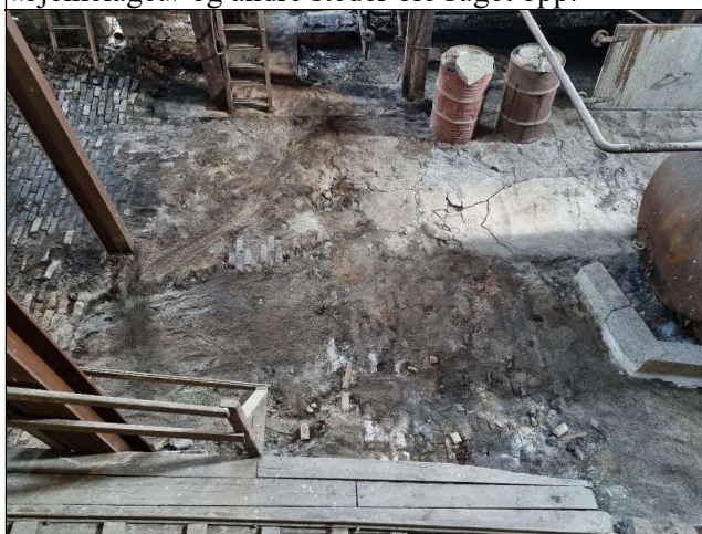
Bilde tatt fra gangbrua langs varpa og østover mot inndampertilbygget (område J) etter sanering.
