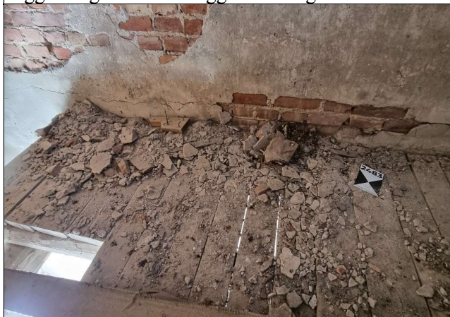
Mikseriloft, sørvegg før sanering. Murpuss fra veggene og annet rask ligger utover gulvene.
