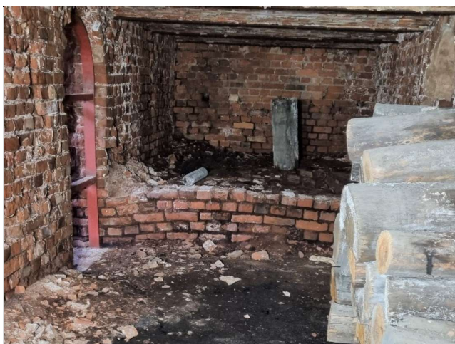
Sørligste del av rommet under varpa før sanering.
