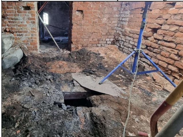
Nordligste del av rommet under varpa før sanering.
