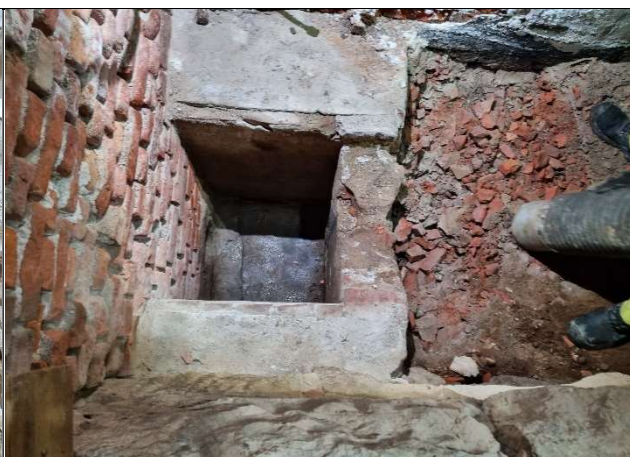
Bilde tatt i remkanalens sørvestre hjørne. Under 20-30 cm sand lå det et lag teglrester. Teglrestene stammer nok fra ett eller annet murarbeide, eller kanskje fra kokeripipa som stod her til rundt 1920?
