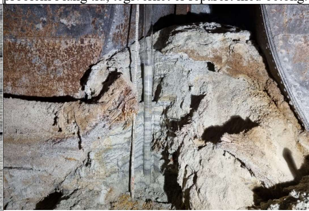
På utvalgte steder ble det presset gjennomslittige akrylrør ned gjennom kalklagene. Rørene blir stående igjen etter saneringen og vil vise kalklag og kalk-nivåer for ettertiden.
