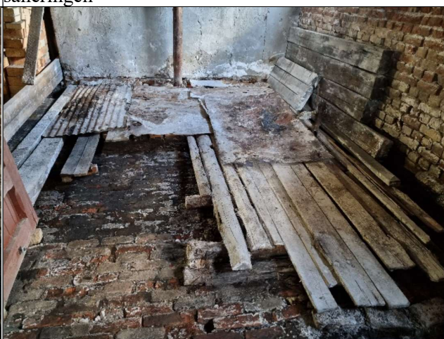
Etter rengjøringen ble alt lagt tilbake på opprinnelig plass.
