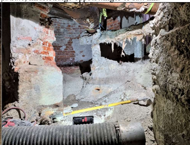
Mye av kalken er fjernet og teglmuren i fundamentet er avdekket. En trebukk som understøtter renna dukker frem fra kalkmassene.
