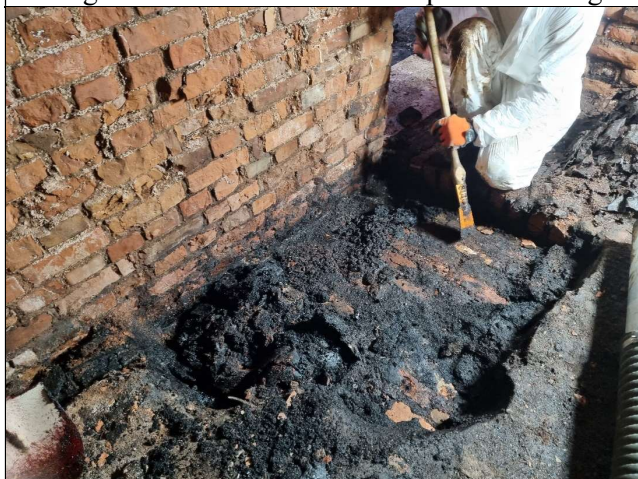
Sørøstre inngang til rommet under varpa. Massene med svartlut ble løsnet med spade og barkespade før de ble sugd opp med vakumsugebil.
