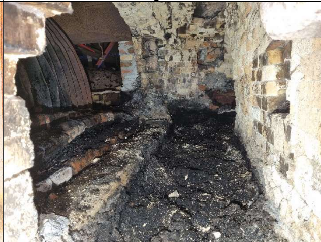
Bilde av varpeovn etter sanering. Et 20-30 cm tykt lag med aske ble fjernet fra ovnen.
