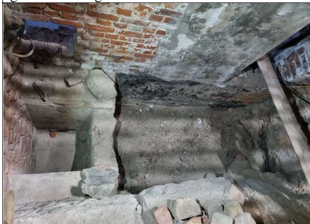
Bilde tatt samme sted. Sand mot teglveggen er fjernet ned til granittfundamentet under veggen. Det svarte på veggen er goudron som var vanlig å bruke for å beskytte mur under terreng.
