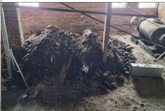
Bildet viser massene som ble fjernet, rundt 2 m 2 . Massene ble midlertidig lagret her, senere ble de trillet ut i container og levert Østlandet Gjenvinning for deponering.
