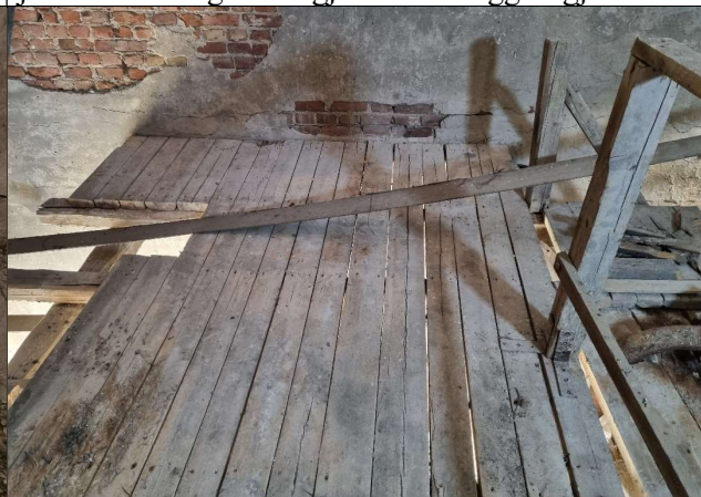
Samme sted etter sanering.
