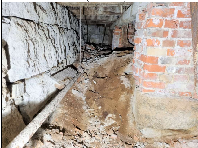
Bilde tatt østover langs luthuskjellerens nordvegg før sanering. Nærmest ses det vestre tegl-fundamentet til de østre silkarene.
