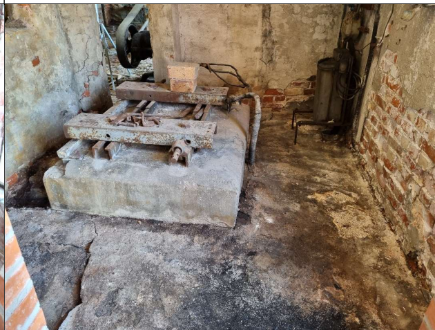
Samme sted etter sanering. I dette rommet ble det fjernet et relativt tynt lag med murpuss og salt som hadde forvitret og falt ned fra vegger og tak.
