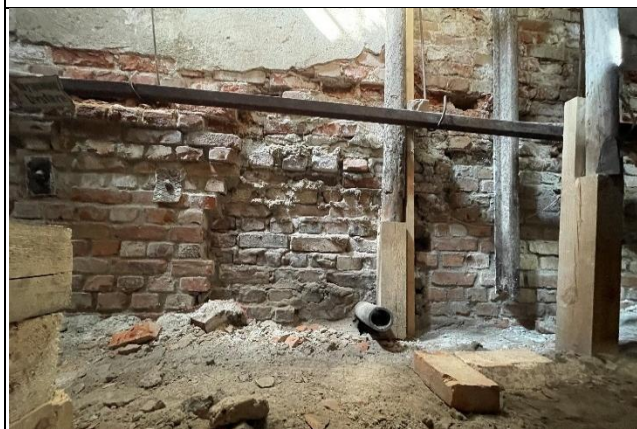
Bilde 5: Murverket i luthuskjelleren er ferdig istandsatt. Konstruksjonen er stabilisert og blitt sikret.
