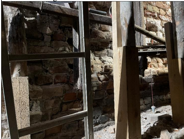
Bilde 5: Nærbilde av veggens midtparti før istandsetting
