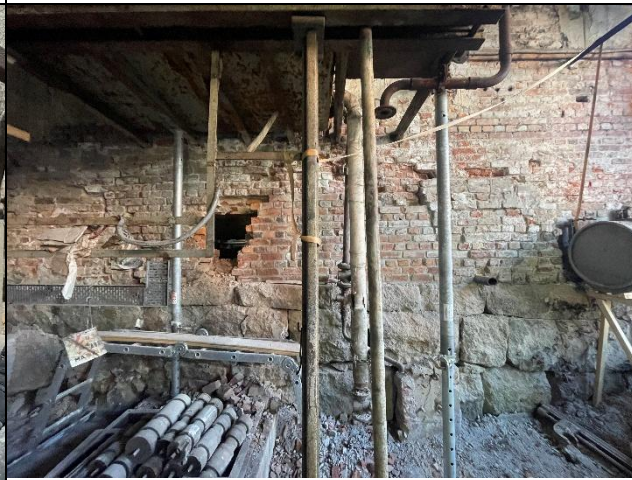
Bilde 4: Felter på ca 60x0 cm ble åpnet opp og remurt under istandsettingen.
