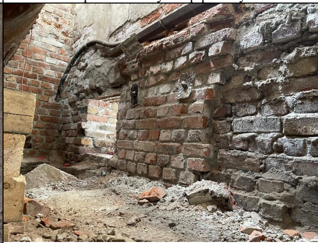
Bilde 4: Murverket er istandsatt. Til høyre i bildet er den sementbaserte reparasjonen på veggens parti mot sør.
