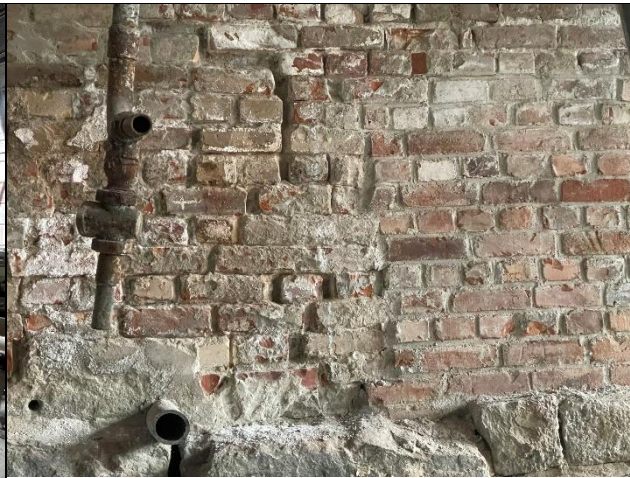
Bilde 2: Istandsettingen er avsluttet mot det sementmurte partiet mot fyrhuspipen i fyrhuset.
