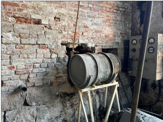
Bilde 1: Tanken på bildet er sikret, og innfesting blir murt inn på nytt.
