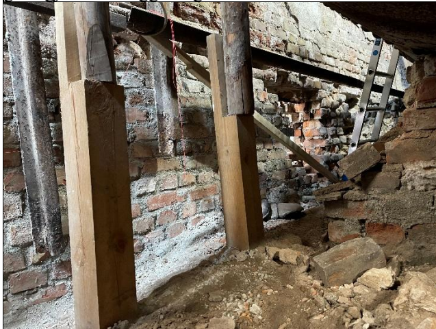
Bilde 5: Sett fra luthuskjelleren. Veggen ble etappevis isandsatt. Sett fra S mot N
