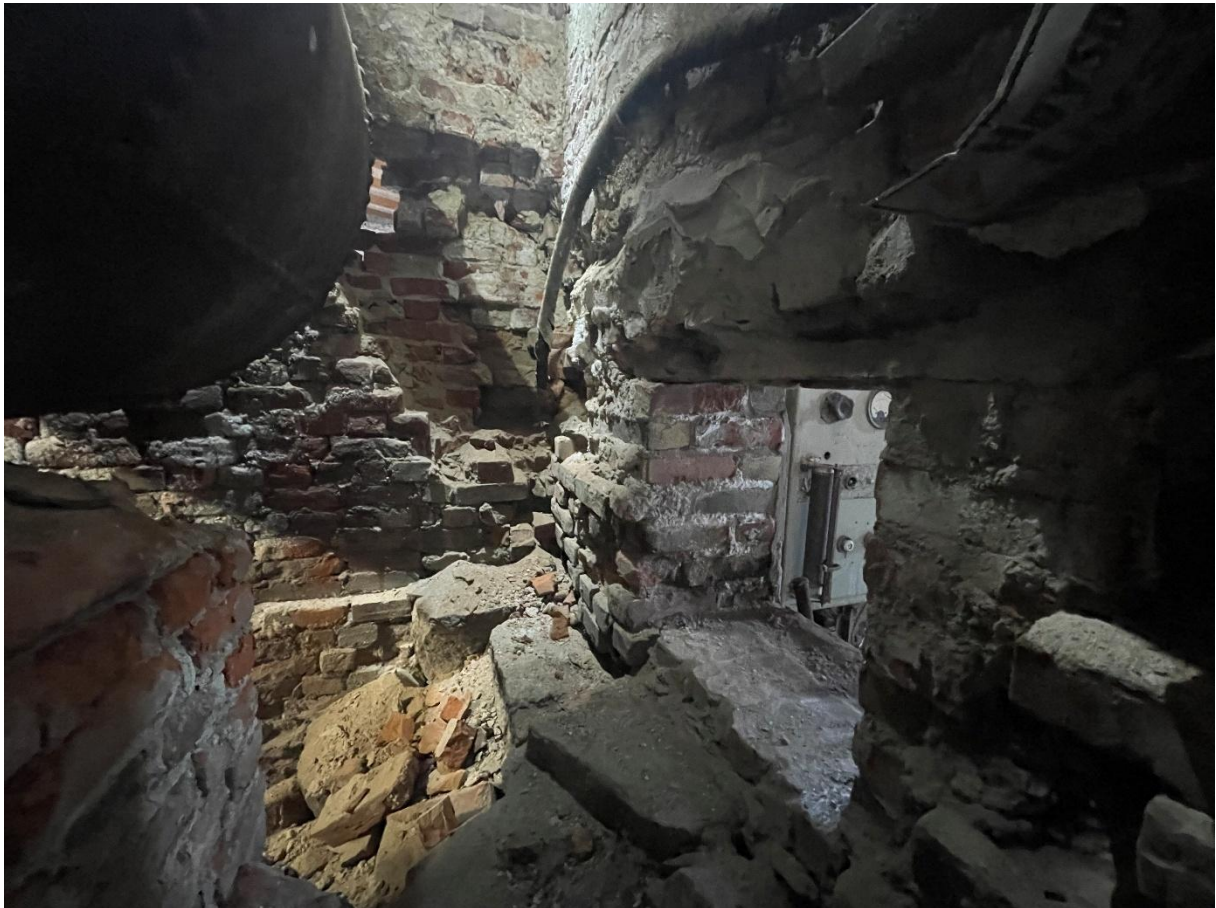
Foto: Anders Nordbakken. Det sørvestre hjørnet i luthuskjelleren før det ble istandsatt
