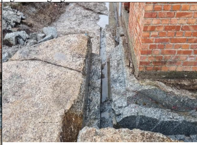
Her er den siste skjæringen kilet ut og fjellet fjernet. Dulpa på østvegg er dypere enn de 50 cm saga kunne sage, dermed får en ikke drenert ut alt vannet. Dette ble løst ved å «forhøye» fjellet med betong.
