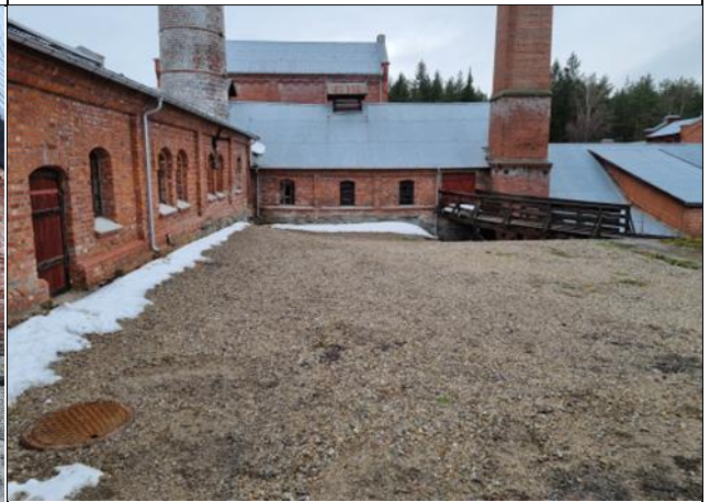
Oversiktsbilde samme sted november 2023. Kummene er kappet ned til terrengnivå og luthusbrua er satt på plass igjen.
