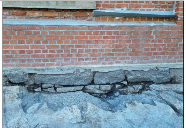
Bilde tatt på sodahusets nordvegg. Bearbeidet fjell synes som mørkere grått parti. 2-3 borehull ble observert på partiet langs veggen.
