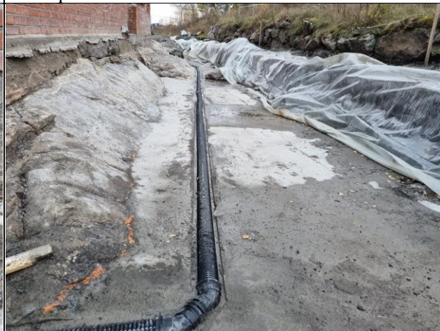
Bilde tatt vestover langs sodahusets nordvegg. Dreneringsrøret ferdig nedstøpt i betongplata som måtte støpes ovenpå morene-leira her.
