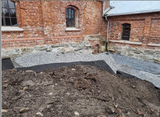
Hjørnet mellom Sodahus og Luthus under igjenfylling. Leiremembran er på plass og pukk langs Sodahus er på plass.
