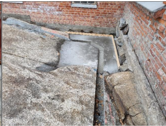
Hjørne mellom sodahus og inndamper-tilbygg. «Fjellforhøyningen» er ferdig støpt med renne for dreneringsrør.
