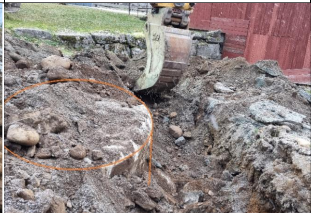
Samme fundament sett mot vasshus. Fundamentet befinner seg omtrent midt i veibanen på veien som går ned bakken forbi vasshuset. Trolig er dette fundament til ei dreieskive, tilhørende ei trallebane som lå i dette området.
