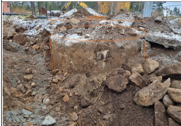
Ett større sylinderformet fundament ble avdekket under grøftegravingen mellom inndamper-tilbygg og vasshus. Fundamentet har en diameter på rundt 2 m og er laget i massiv betong
