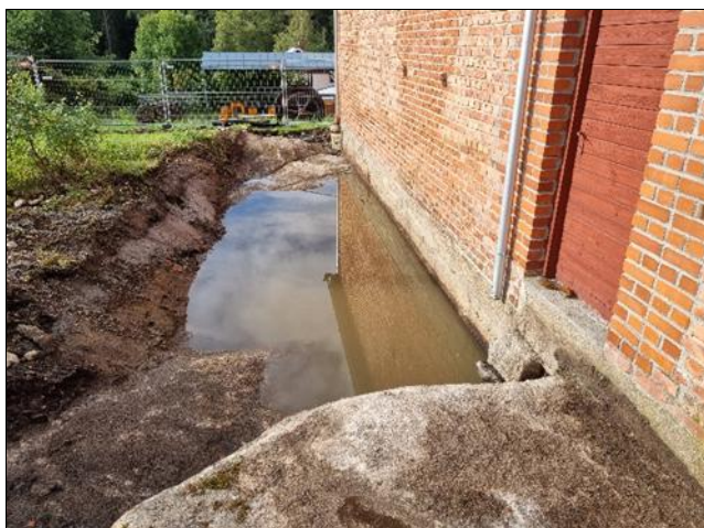
Inndamper-tilbyggets østvegg, bilde mot sør. Grunnfjellet er avdekket, en dulp i fjellet skaper en dam inn mot byggets grunnmur.
