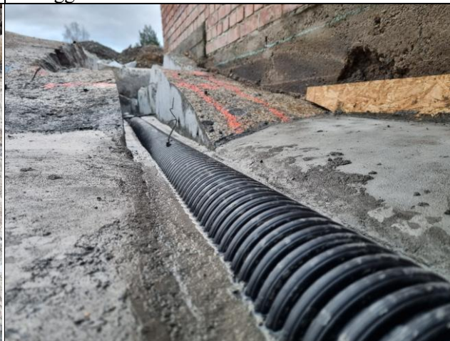
Nærbilde fra samme sted, men i motsatt retning viser fall på betong og overgang til fjellgrøft. Grønn strek på grunnmur viser planlagt terrenghøyde.
