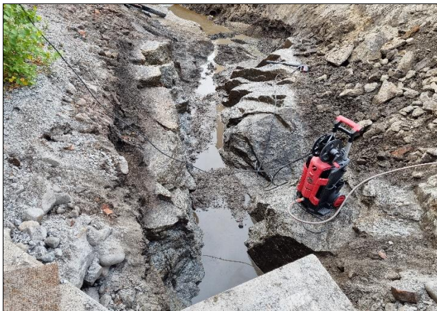
Grunnfjellet ble spylt rent, slik at saging av grøftetraseer i fjellet ble mulig.
