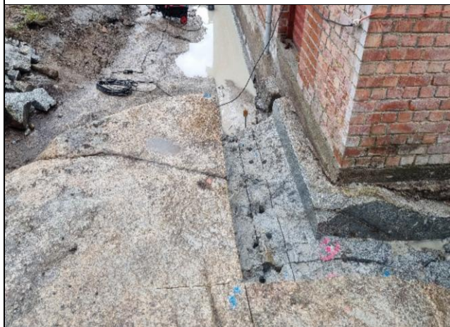
Her er fjellet i grøftene kilet ut og fjernet. Det er saget på nytt i grøfta nærmest kamera og boret for ny utkiling. Dreneringsgrøfta her på hjørnet blir 90 cm dyp på det dypeste.
