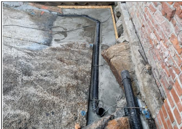
Hjørne mellom sodahus og inndamper-tilbygg, tatt mot sør. Nærmest kamera, dreneringens «vannskille» hvor det skal etableres kum for varmekabel m.m.
