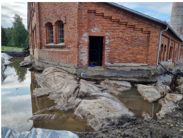
Nordvegg sodahus. Grøftene er ferdig gravd og fjellet rengjort. En fjellrygg som strekker seg fra døra og vestover skaper en naturlig dam. Her har det regnet en helg og vannet i grøfta har steget 50-60 cm før det har rent over fjellryggen.
