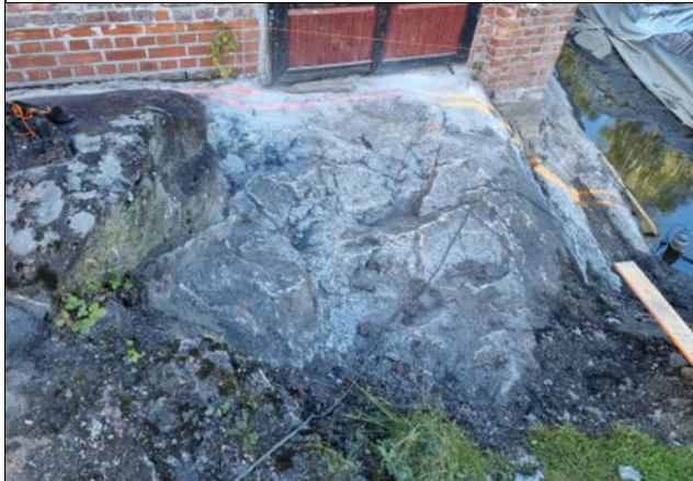
Bilde tatt på sodahusets østvegg. Foran dørene her har det blitt fjernet fjell.
