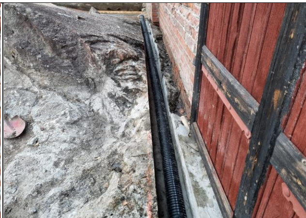
Bilde tatt sørover langs sodahusets østvegg med dør inn til brannpumperom. Dreneringsrør ferdig nedstøpt.
