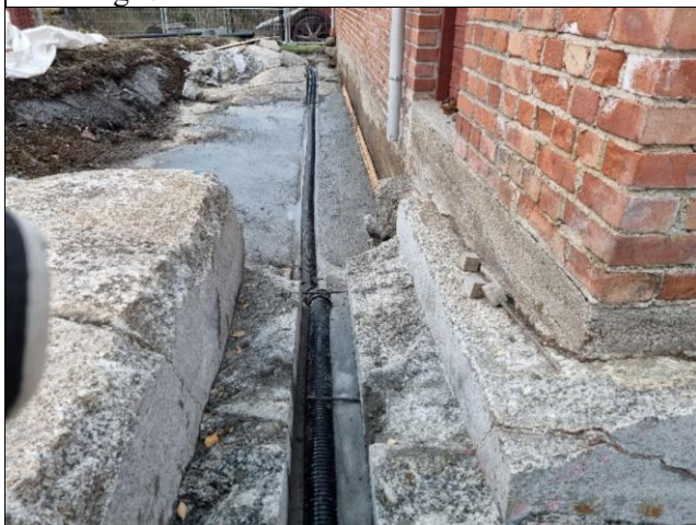
Inndamper-tilbyggets østvegg, bilde mot sør. Dreneringsrør er montert og nedstøpt i renna.
