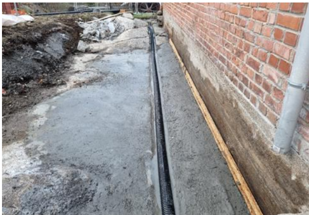
Samme sted som forrige bilde. Deler av dulpa i fjellet er fylt med ei betongplate med fall inn mot drensørret. På hver side av dulpa er drensørret lagt i grøfter skåret ned i fjellet. Inn mot grunnmur er det montert ei OSB plate som skiller betongplata fra byggets grunnmur.
