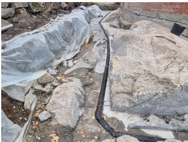
Bilde tatt samme sted. Nå er det slisset ned ei grøft gjennom fjellryggen og dreneringsrør er støpt ned i fjellgrøfta. På den borteste delen her var det en dulp i fjellet, på den strekningen ble det støpt ei betongplate for drenerørret.
