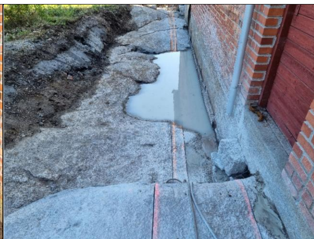
Her er dreneringsgrøftas sider saget. Det er saget 50 cm dypt i forhold til fjellets høyeste punkt. Nærmest kamera er det saget 60 cm bredt siden det her skal sages en omgang til.
