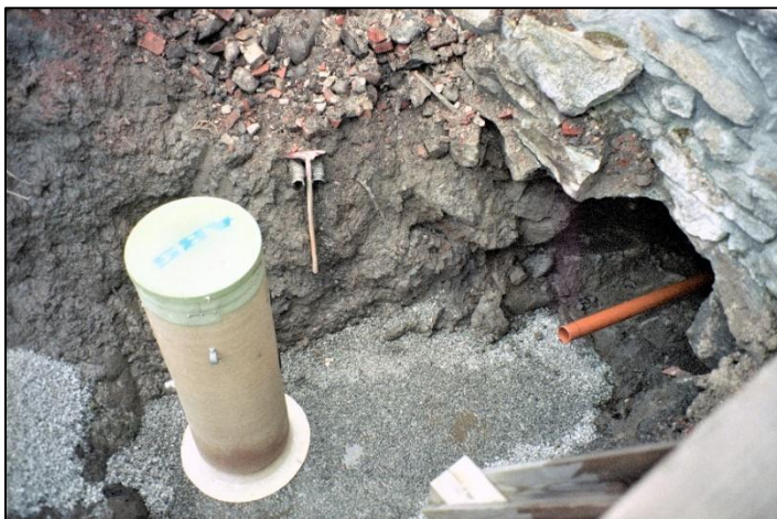
Foto: Even Østlund. Bildet er fra innføring av vann og avløpsledninger i 2004. Denne grøftetraseen med pukk fungerer som en dreneringsgrøft for området nord for fabrikk og fører vannet inn mot luthuskjelleren. Krafsa henger på de avgravde drenerørene fra 1980 tallet. I bunn av grøfta ses stående vanddammer.
