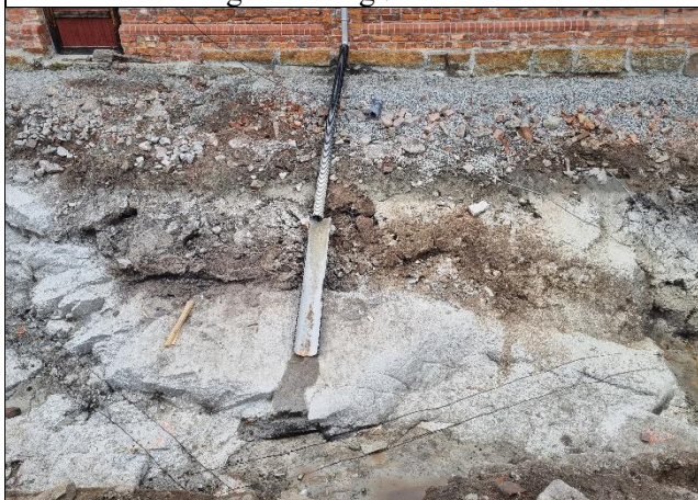
Midt på langvegg sodahus. Grøftekantene ferdig saget i fjellet. Føringskinnene for saga ble montert slik at grøftebunnen fikk fall riktig vei.
