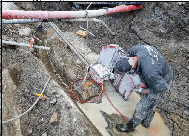
Morten Voldmo i gang med å sage grøftekantene. Saga føres på ei skinne boltet til fjellet.
