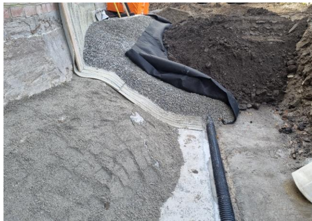
Nordvegg sodahus, dreneringen under igjenfylling. Til venstre ses grunnfjellet dekket med subbus. Subbusen er lagt på for å jevne ut dulper i fjellet slik at leiremembranen får et godt underlag. På subbusen ligger det en leiremembran fra terrengoverflaten og ned til dreneringsrøret. (den hvite streken på grunnmuren viser planlagt terrenghøyde) Membranen er dekket med et drenerende lag pukk og over pukken ligger en svart filteringsduk for å hindre finstoffer fra å trenge ned i pukk og dreneringsledning. Nederst ses drensørret nedstøpt i betong. Betongplaten har fall inn mot dreneringsrøret fra begge sider. Betongen når opp til slissene i drensørret slik at vann som følger betongen ender opp i røret.
