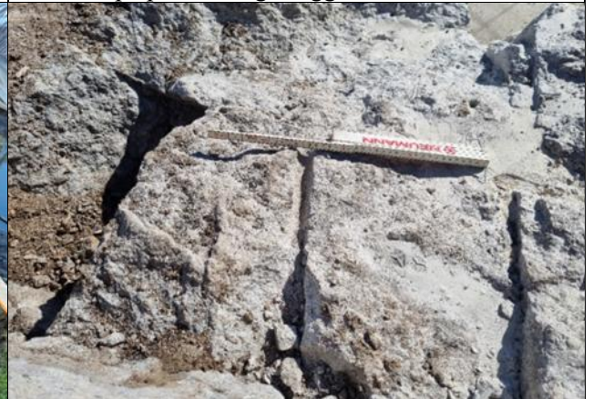
Bilde tatt på inndamper-tilbyggets sørøstlige hjørne. 25 mm borehull og fjellets overflate avslører at fjellet er bearbeidet.
