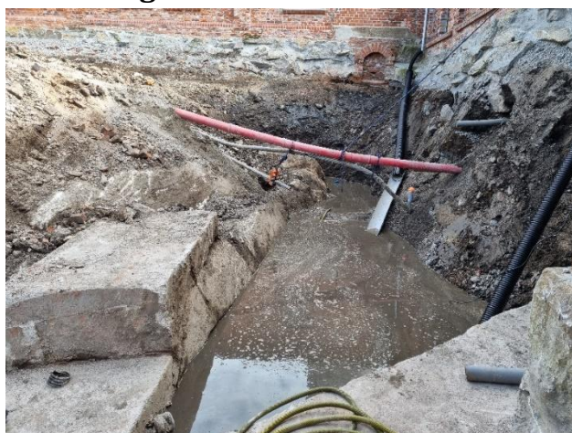
Nederst i bildet (med grønn vannslange) ses betongbanketten som på 1980 tallet ble støpt mellom luthuskjeller og fjellskjæring nord for bygget. Banketten skaper en 60 cm dyp underjordisk dam inn mot bygget
