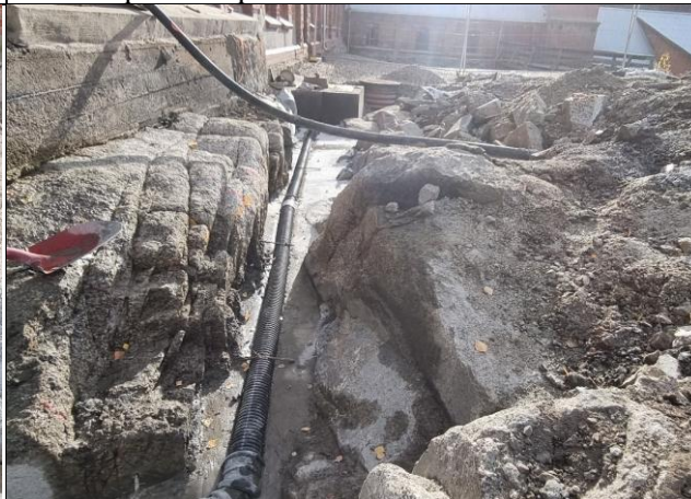
Bilde tatt sørover langs sodahusets vestvegg. Røret ferdig nedstøpt i den utvida, naturlige renna i fjellet. Røret svinger forbi den historiske kummen og ender opp i den nye kummen en skimeter bak. Det kryssende elvestadrøret er vanntilførsel sodahus.
