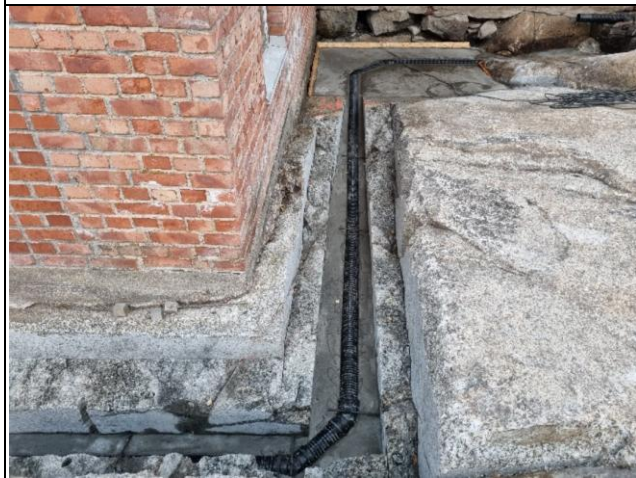
Hjørne mellom sodahus og inndamper-tilbygg. Bilde tatt mot vest. Dreneringsrøret ferdig nedstøpt. I 90° hjørner er det brukt 45° bend.
