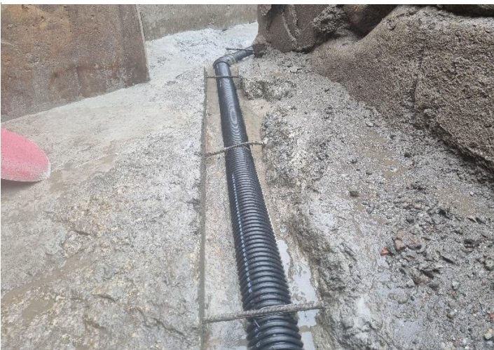
Grøft slisset ut i fjellet, drenerør lagt og nedstøpt.
