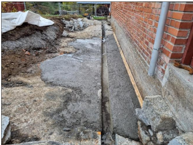
Inndamper-tilbyggets østvegg, bilde mot sør. «Fjellforhøyningen» er ferdig støpt med renne for dreneringsrør.
