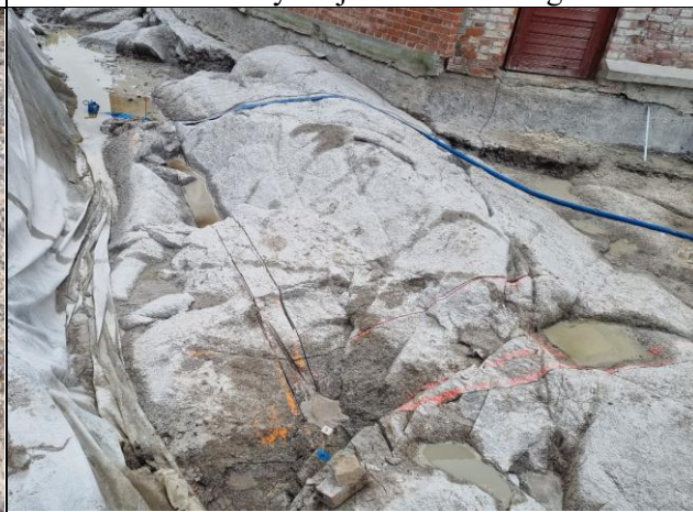
Bilde tatt østover ved sodahusets nordvestre hjørne. Grøfta er saget. Gjennom fjellryggen må det sages i to omganger, grøfta er derfor saget 60 cm bred der.
