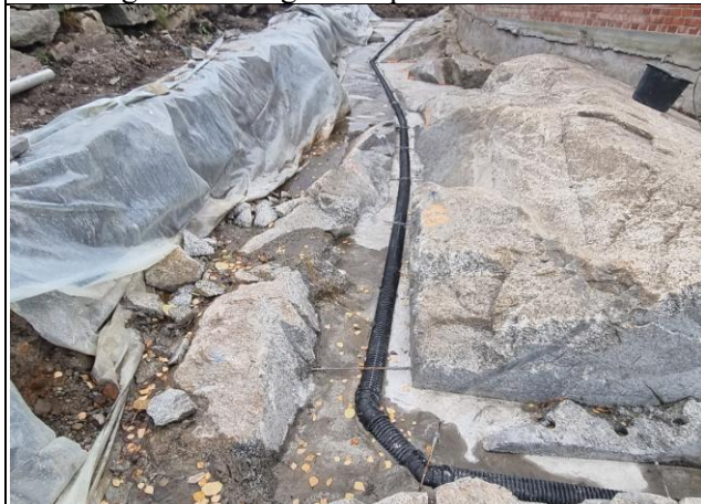
Bilde tatt østover langs sodahusets nordvegg. I nedre bildekant svinger røret sørover og skjærer gjennom fjellryggen som før hindret vannet å drenere sørover. (mellom dette og neste bilde er det 6-7 m rør som det ikke er bilde av)
