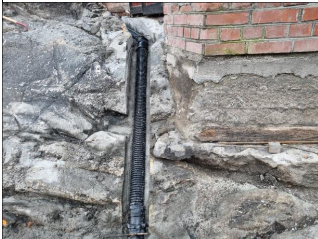
Bilde tatt sørover langs sodahusets østvegg med dør inn til brannpumperom i øvre bildekant. Dreneringsrøret ferdig nedstøpt.
