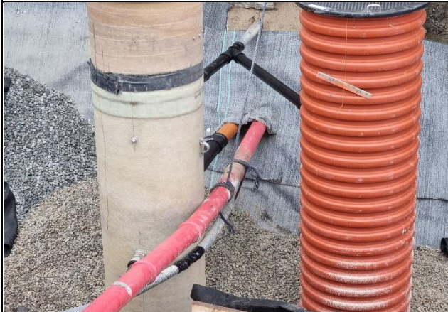
Kloakkum til venstre og ny drenskum til høyre. Det øvre røret fører strøm til pumpe i kloakkum og varmekabel til drenskum. Det røde er for fiberkabel mens det grå under er trekkerør for vannledning med varmekabel. Trekkerøret ble skadet under graving og reparert med krympeplast.
