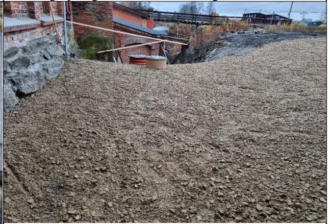
Bilde tatt vestover langs luthus. Området er ferdig planert og det er lagt 12-15 cm bærelag over de stedlige massene. Det ble laget 15-20 cm fall fra luthusveggen til et lavbrekk som ender opp rett på yttersiden av kummene.
