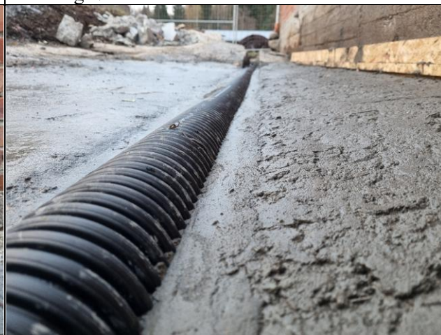
Nærbilde samme sted. Dreneringsrøret er nedstøpt opp til dreneringsslissene. Betongen har fall mot røret fra begge sider.
