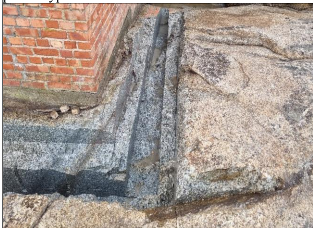
Bilde fra samme hjørne, tatt mot vest. Dreneringsgrøfta ferdig. Også her var dulpa dypere enn grøfta og fjellet måtte forhøyes med betong.
