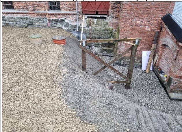
Bilde tatt mot luthus, Pipe og fyrhus til høyre. Området er ferdig igjenfylt og planert.
