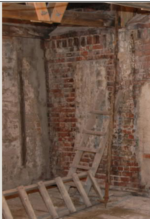
Figur 1: Hjørnet mellom gavlvegg og teglpipe fra 2005 Figur 2: Hjørnet mellom gavlvegg og teglpipe fra 2024
