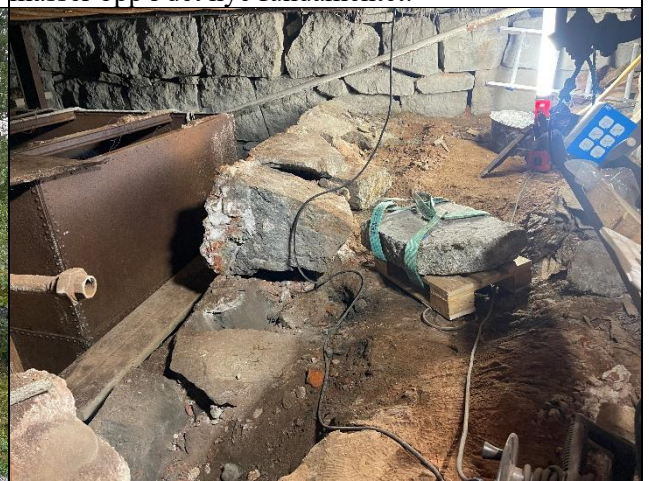
Bilde 15: Vi har heist ned første steinen og begynner å mure granittmuren bredere sånn at den blir bred nok til teglkonstruksjonen.
