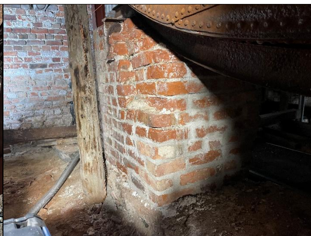
Bilde 37: Fundamentet lengst mot sør som ikke ble sanert vekk i 2023 har blitt vedlikeholdt,
