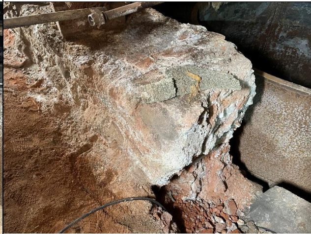
Bilde 6: Betongfundamentet under det sørligste av de to sandfiltreringskarene.
