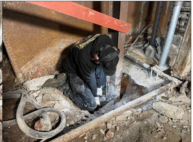
Bilde 11: Stein Dybvad fra Ilseng maskin borer gjennom søylen for å montere inn 20mm rundstål
