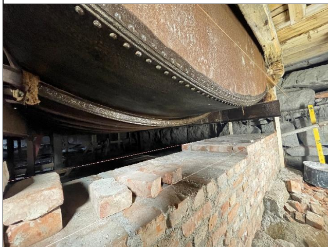
Bilde 26: Undersiden av sandfiltreringskaret og de delene av jernbjelkene som senere blir utilgjengelige er korrosjonsbehandlet. Sett fra S mot N.
