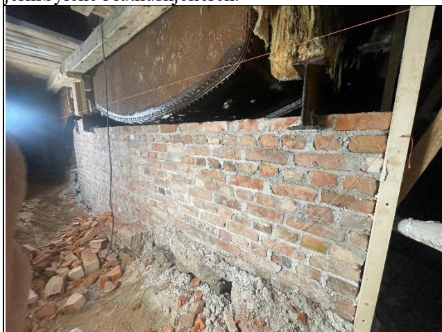
Bilde 38: Teglfundamentet er ferdig og sandfiltreringskarene er lagt an på det nye fundamentet. Sett fra NV mot SV
