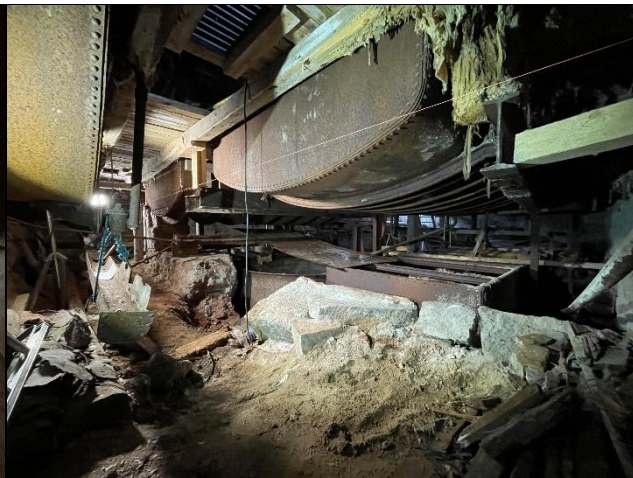
Bilde 2: Sett fra N mot S før remuring av fundamentene.
