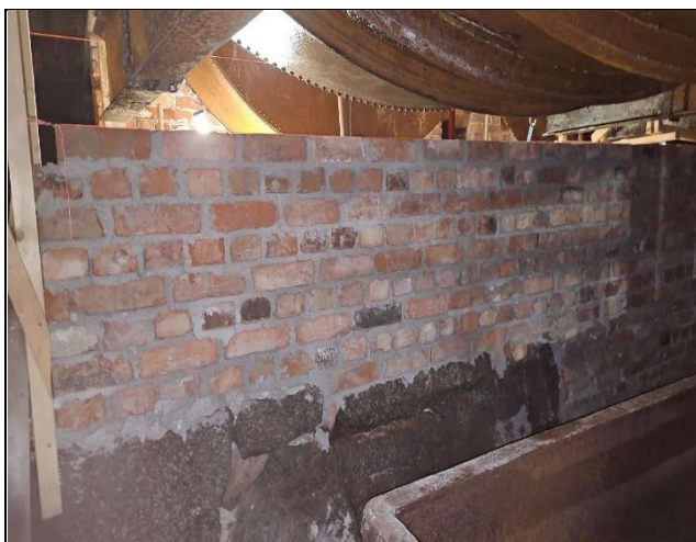
Bilde 30: Baksiden av teglfundamentet. Det gjenstår ett skift for å komme oppunder stålbjelkene som skal legges an på murverket. Sett fra Ø mot V
