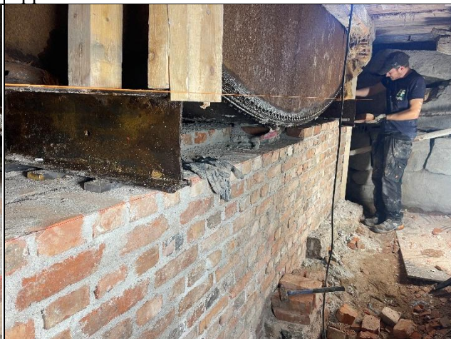
Bilde 35: Knut Are Sagerud murer det siste skiftet etter at sikringskonstruksjonen er fjernet.
