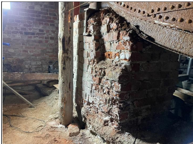
Bilde 7: Fundamentet lengst mot S ble ikke sanert vekk i 2023. Fuger ble respektert og fire steiner måtte skiftes.
