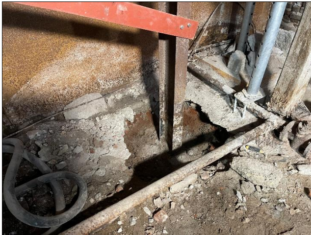
Bilde 10: Vi fjernet forvitret betong og gravde ned for å avdekke fundamenteringen på den sørligste jernsøylen.
