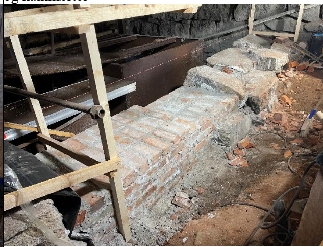
Bilde 21: Vi begynte å mure tegl der hvor granittmuren var lavest. Det er lagt papp mellom betongfundament og den nye teglmuren.
