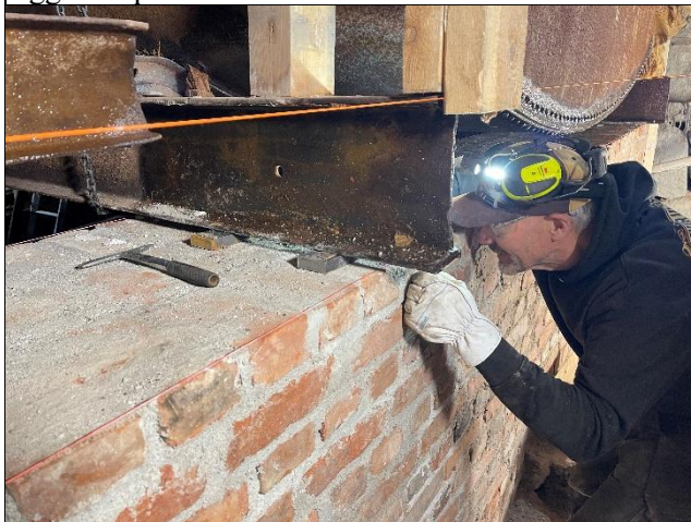
Bilde 32: Stålbjelkene som ble lagt an på murverket hadde ulike mål mellom bjelke og murverk. For å få god kontakt ble det lagt inn stålskims
