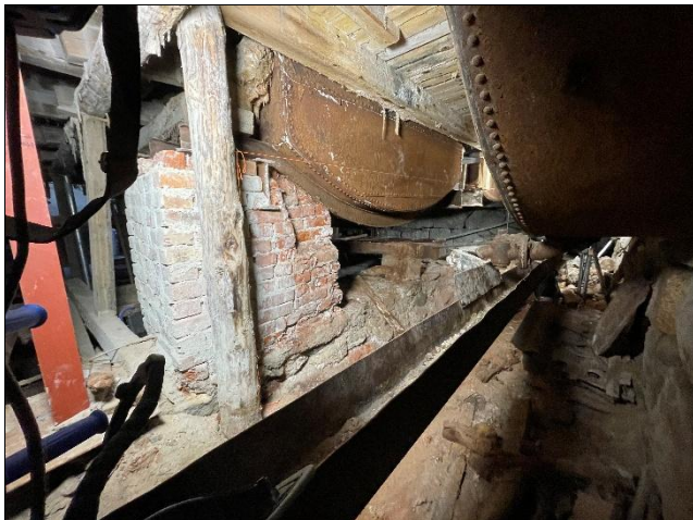
Bilde 1: Sett fra S mot N før remuringen av fundamentene.
