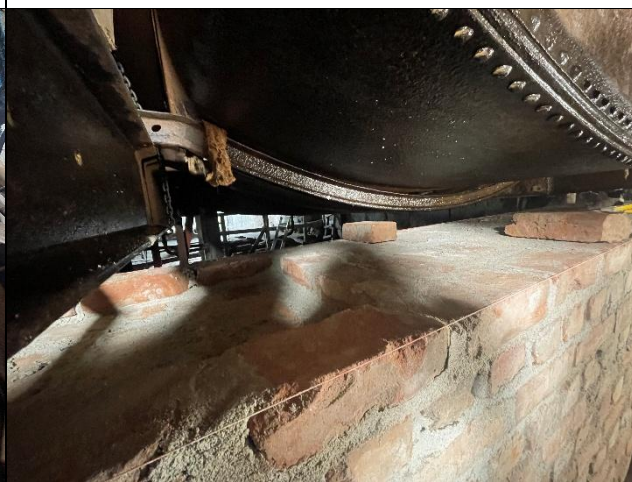
Bilde 29: Siste skift før det mures oppunder stålbjelkene som skal legges an på muren
