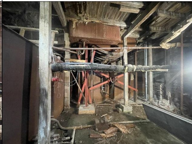
Bilde 10: Kjelleren og fremre del av lutkarene før oppstart. Sett fra V mot Ø
