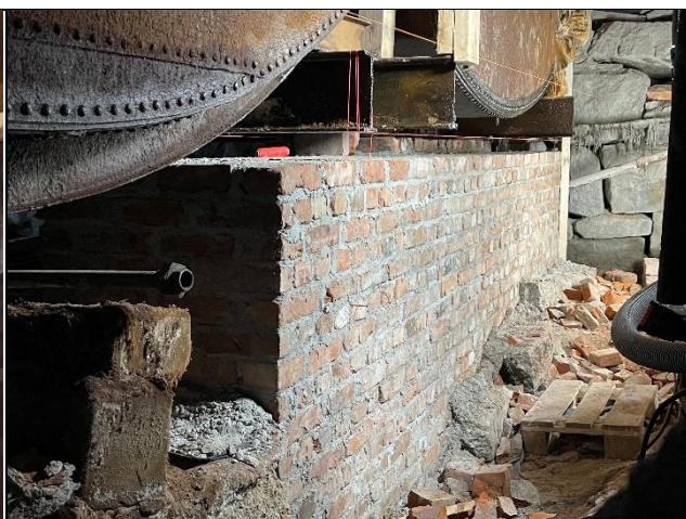
Bilde 31: Framsiden av teglfundamentet. Det gjenstår ett skift for å komme oppunder stålbjelkene som skal legges an på murverket. Sett fra S mot N
