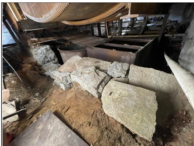
Bilde 16: Granittmuren mures bredere for å bli bred nok for den 1,5 steins tykke teglkonstruksjonen. Sett fra Ø mot V.
