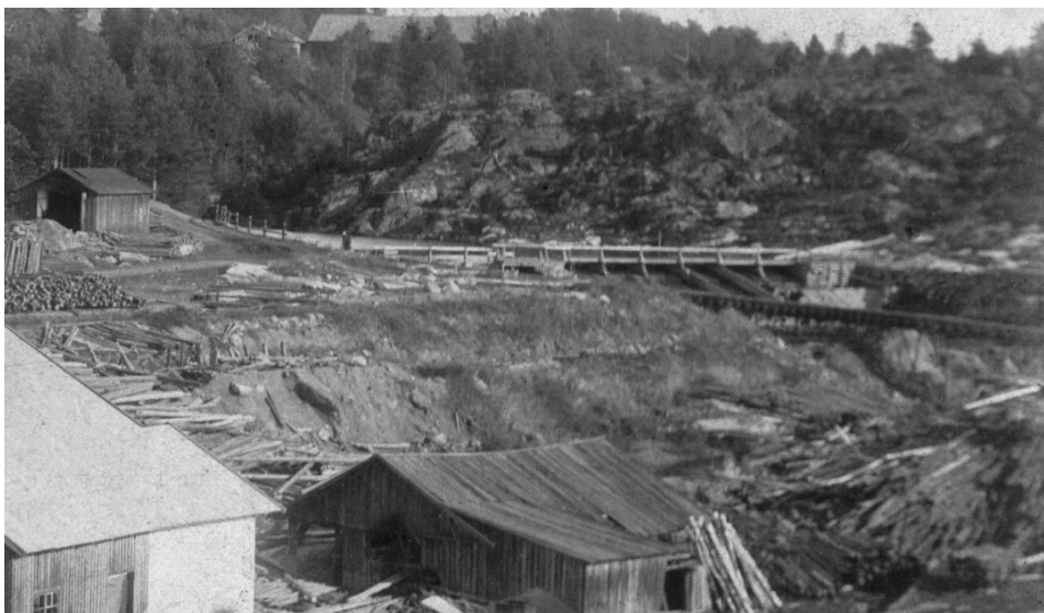
Foto: Chr. Kielland/Digitalt museum. På dette utsnittet av fotoet vises dammen fra en annen vinkel, men den ser ut til å være rimelig lik postkortbildet stemplet 1904. Bildet har usikker datering og kan være tatt allerede i 1892. «Lokstallen» har kledning av stående bord og ser ut til å ha en annen plassering og fundament enn på 1904 fotoet, et tegn på at dette fotoet er eldre enn 1904 fotoet?
