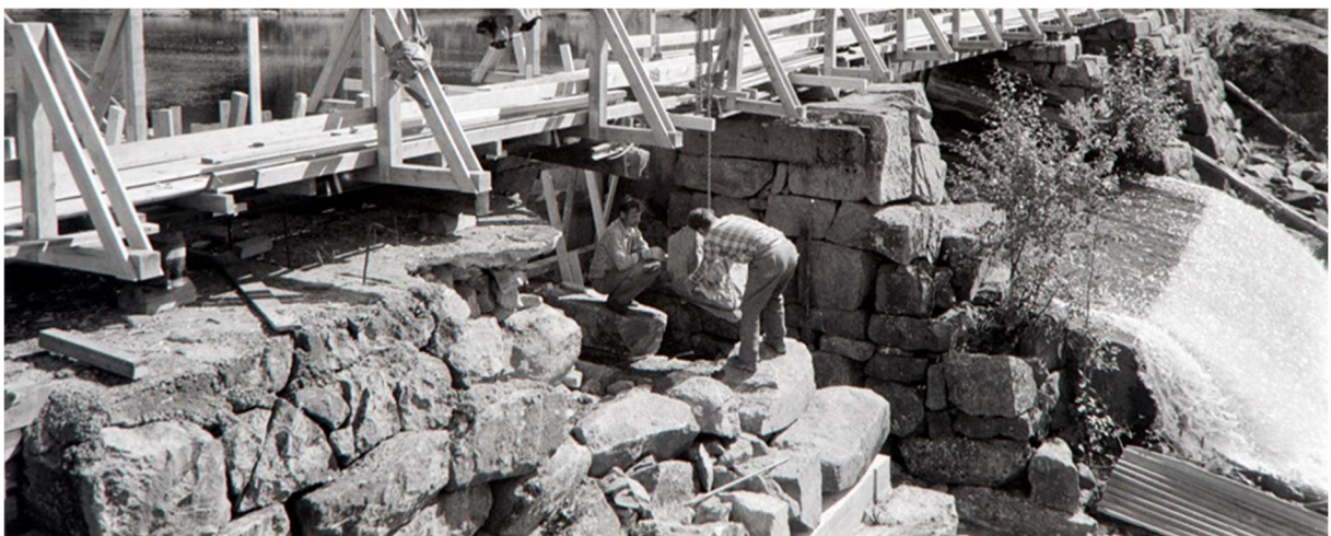
Foto: Klevfos Industrimuseum/Digitalt museum 1989. Her er gråsteinsmuren under re-muring med mobilkran. Etter at muringen var fullført, ble det støpt dekke på damkrona der dette manglet. I betongen er det skrevet inn 28-8-1989.
