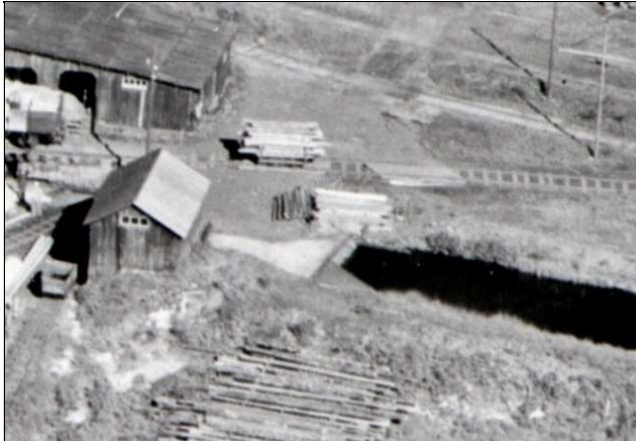
Flyfoto fra 1951 (Digitalt museum 0415-00692) viser kulvert og inntaksrist. Vannstanden anslås å være 50-80 cm lavere enn kulverten.
