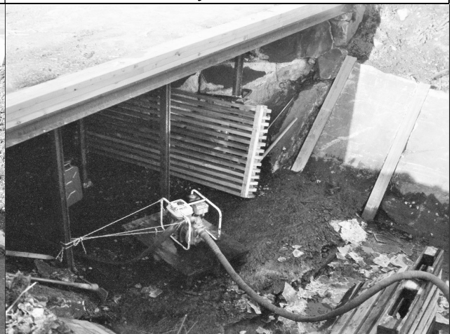
Samme tidspunkt, litt annen vinkel. Nytt treverk til innfesting av spilerister og rekkverk er lagt i fremkant kulverttak.
