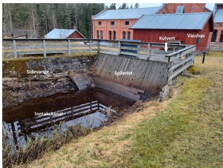
Foto: A. Teppen 2024. Bildet viser inntakskanalen med sidevanger, spilerist, kulvert og vasshus. Fotografen står på nordsiden av kanalen og bildet er tatt mot vest, sørvest.
