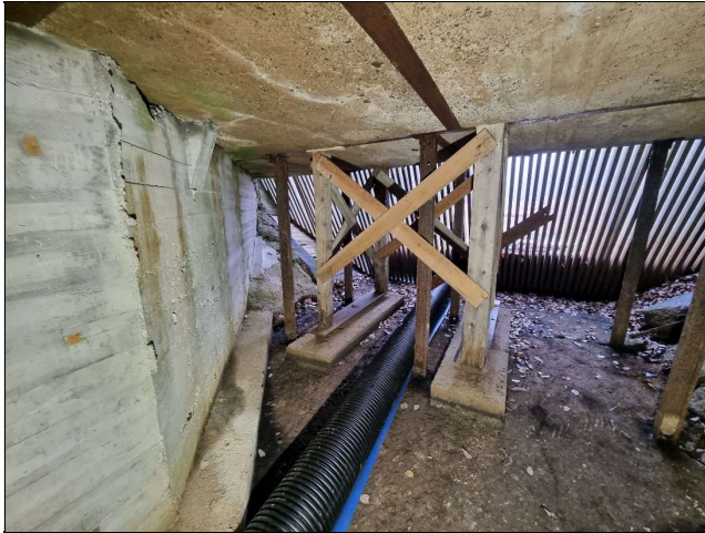
Bilde av den nordre traktutvidelsen. Betongveggen fra 1999 til venstre. En kan se rammeverket og stolpene av jernbaneskinner som danner den opprinnelige, bærende konstruksjonen.
