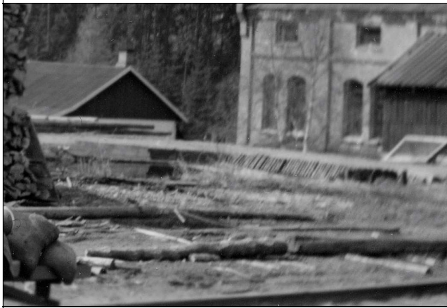
Foto fra 1959-63 (Digitalt museum SJF-F.006735) En kan se inntaksrista og betongveggen foran brannkummen. Vannstanden anslås også her til å være 50-80 cm under topp kulverttak.
