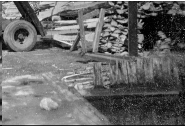
Foto fra 1959-63 (Digitalt museum SJF-F.006736) viser nordre del av kulvert/inntaksrist og en spuntvegg langs nordre kanalkant. Det antas at spuntveggen ble erstattet med betongvange i 1993. Det ser ut til at spuntveggen har stående bord med kryssende horisontale bord.
