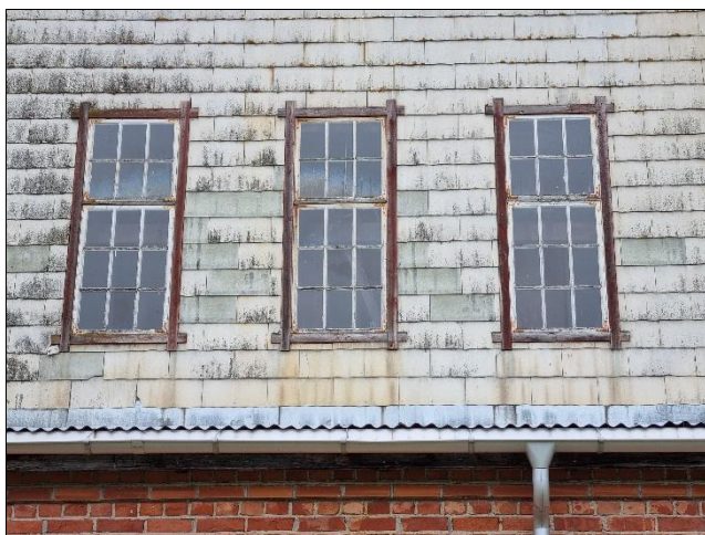
Østsiden av Sodahuset fikk et større tilbygg i 1956. I dette tilbygget ble det benyttet trevinduer.
