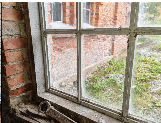
Trevindu sett fra innsiden viser opprinnelig hvit maling og falser med mulighet for 2 lag glass.
