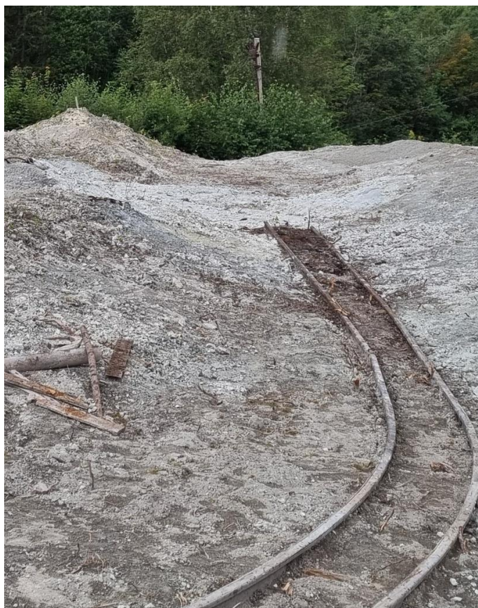
Bilde tatt etter fjerning av vegetasjon i 2025. Brua over elva er borte, men en god del av trallebana er fremdeles på plass og er nå synlig igjen for første gang på mange år. Trallebaneskinnene som ble funnet lenger vest på kalkhaugen er trolig rester etter trallebanene som lå i forlengelsen av der trallebana ender i dag. Strukturen med kalkrygger på hver side av trallebanesporet er fremdeles intakt. Når en er på plassen er det også lett å lese hvor traséen etter trallebana som svingte til venstre har gått. I venstre bildekant ses en liten ansamling av metallgjenstander som dukket opp i kalken.
