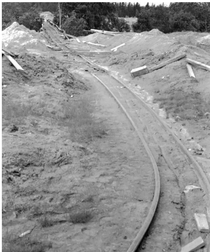
Bilde tatt av trallebane og kalkhauger i 1972 (foto: Digitalt museum JMF-CFT-0832) Brua over svartelva til deponiet på sørsiden er fremdeles intakt. Strukturen med kalkrygger langs hver side av trallebana forteller om hvordan kalken ble trillet ut og dumpet/måket av kalkvaggen langs trallebanesporet. En ser også at sporet deler seg med en sving ut mot venstre. Også i dag har kalkryggen et brudd som viser hvor dette sporet svingte ut.
