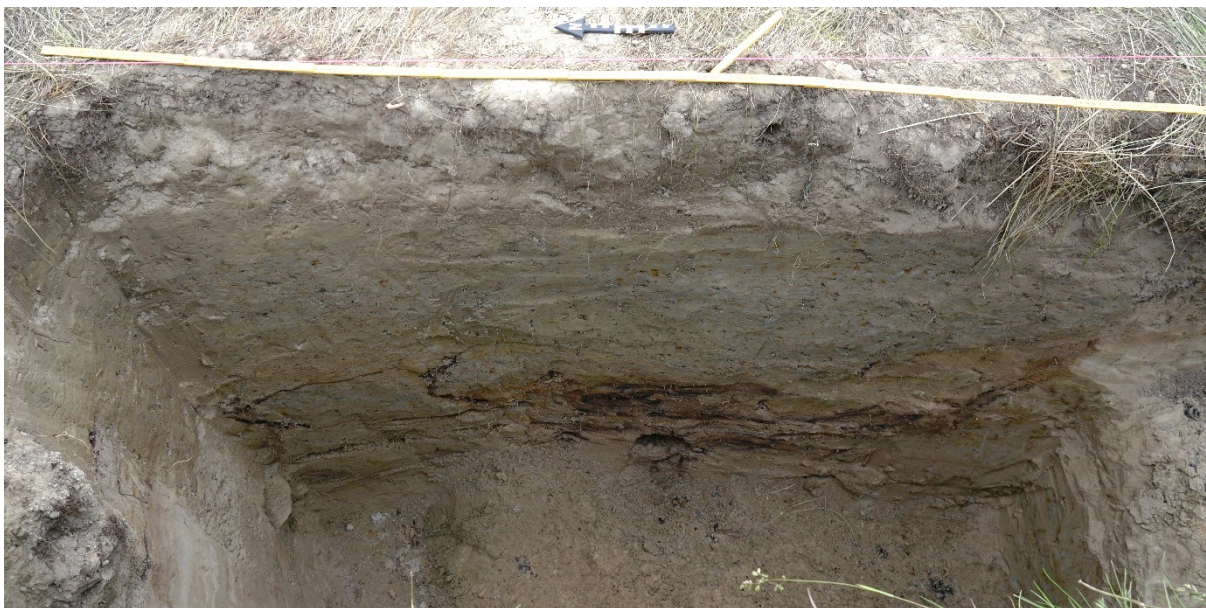
Figur 13. Gropen i schakt 1, norra delen av profil 5 mot öster.
