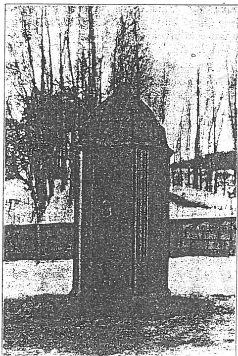
Fig. 5. Kiosk ved Drammensveien, tegnet av arkitekt Erik Glosimodt.
