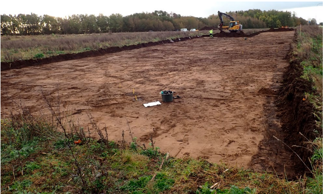
Figur 4. Vy från undersökningsområdets nordvästra hörn. Patrik följer avbanningen och märker ut anläggningar med gula träpinnar. Foto mot SSÖ. Fotonummer: 2025–2:4. Fotograf: Linda Wigert.
