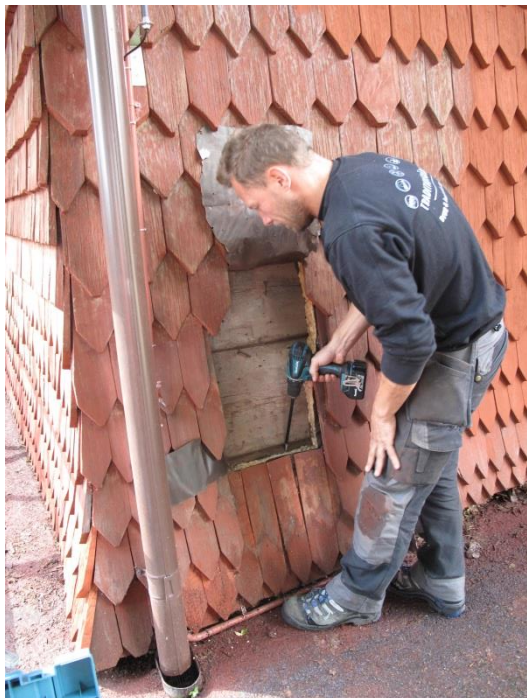
Proven tas på sakristians norra fasad i de nedersta stockvarven.
