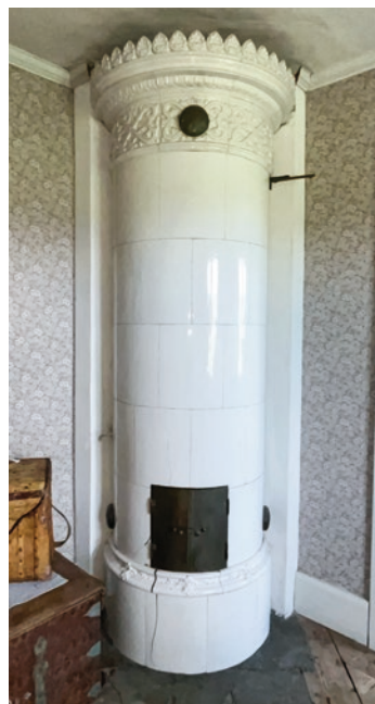
Både vedspis och kakelugn är viktiga värmekällor i äldre hus. Både för komforten och för att hålla grunden torr. Foto: Johanna Ullsdotter.
