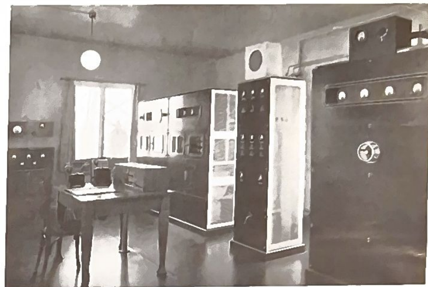
Fig. 4. Interiör från Hudiksvallstationen (1 kW Standard-sändare). Längst till vänster styrsändaren, placerad ovanpå ett skåp innehållande reläer och larmklocka. Örnas för styrsändarens moduleringsmätaren och apparaten för övermoduleringslarm. Till höger om följande likriktarreläet, 250 W stativet och 1 kW stativet. På bordet kontrollmottagare och ledningsväxel samt manövrerings- och larmapparater.
